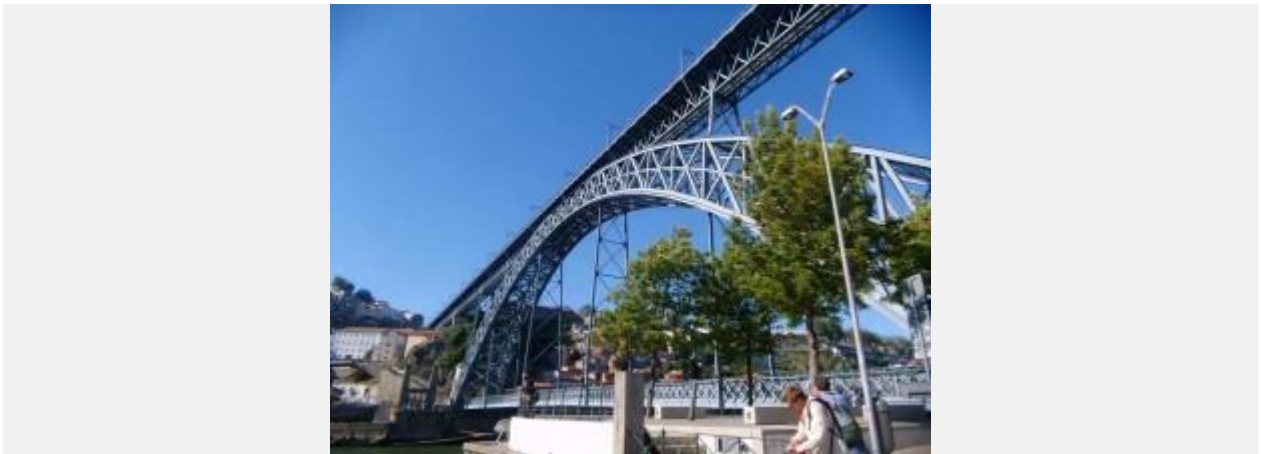
Die große Brücke über den Fluß, eine beeindruckende Stahlkonstruktion
