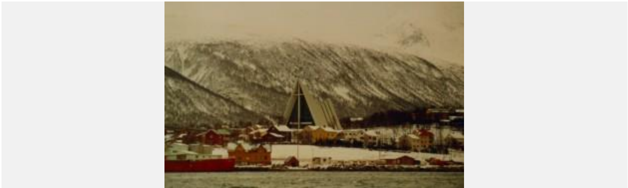
Die Ishavskathedrale in Trömsö
